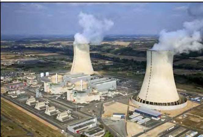
La centrale nucleare di Civaux, nella Vienne, uno dei cui due reattori è fermo dal 10 settembre dopo la scoperta di anomalie nell'acciaio dei generatori di vapore. Il secondo reattore sarà fermato nel corso del 2017 per analoghi controlli. [da Le Monde ]
